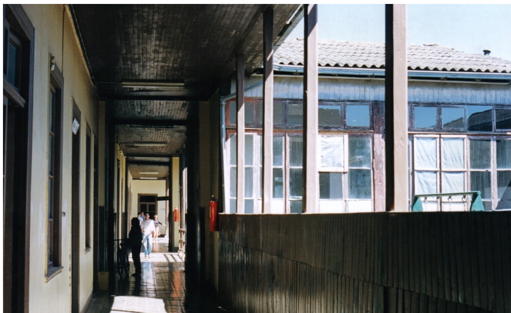
Figura 1.4: Antigua área administrativa.
