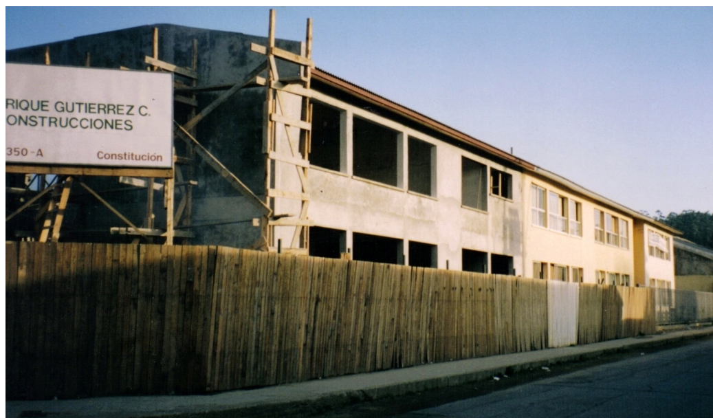
Figura 12.5: Por Portales, la construcción llega a la esquina de Oñederra (año 1994).
