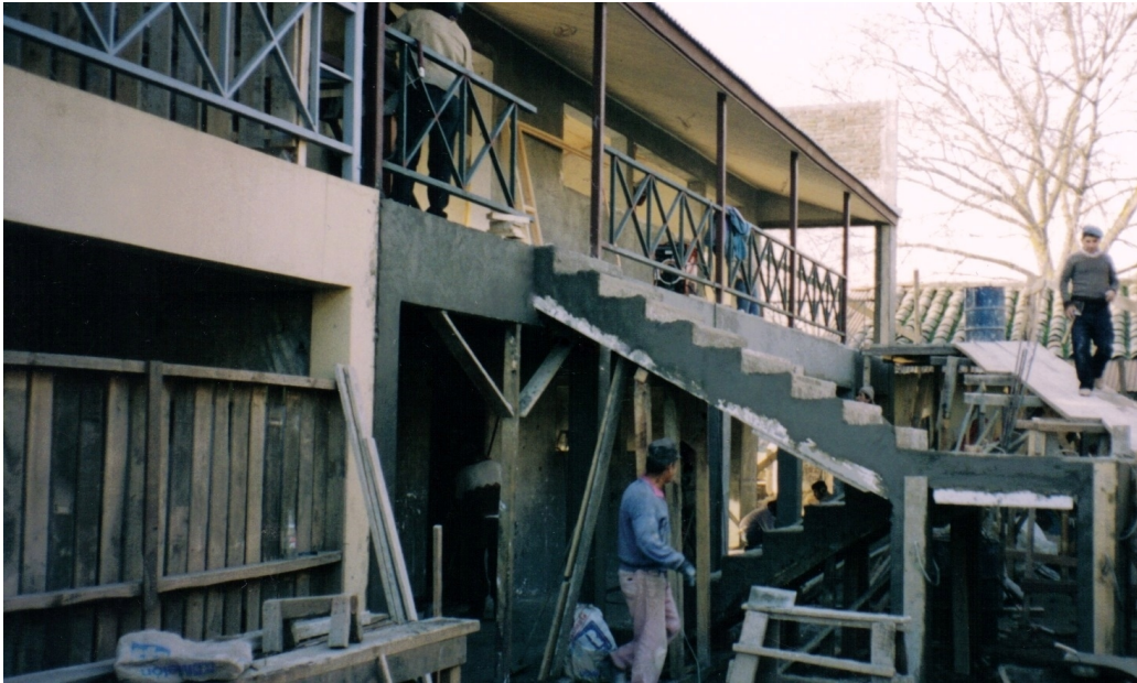
Figura 12.3: Avanza la construcción de salas por Portales hacia calle Oñederra (año 1993).
