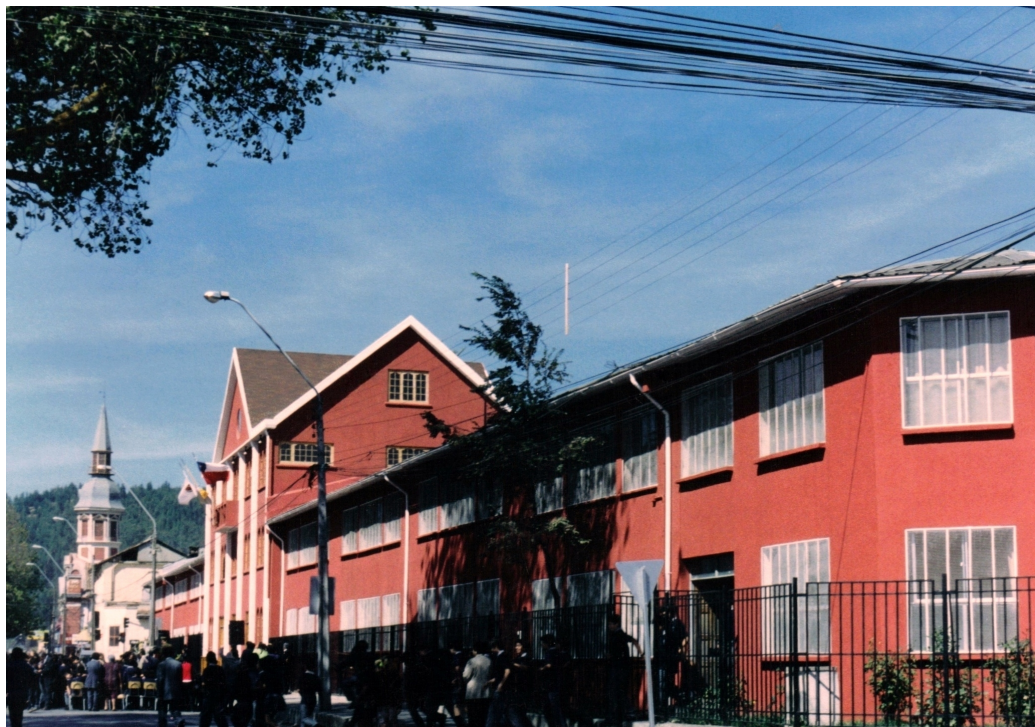
Figura 12.10: Vista panorámica del colegio por calle Oñederra. Al fondo, el templo parroquial.
