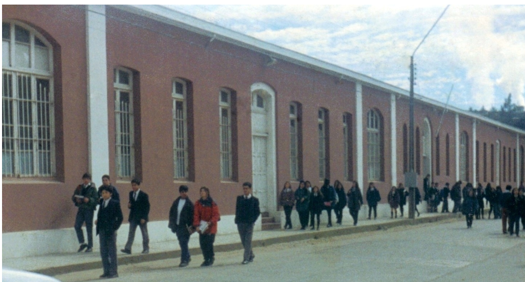
Figura 1.3: Frontis del colegio, hacia calle Portales.
