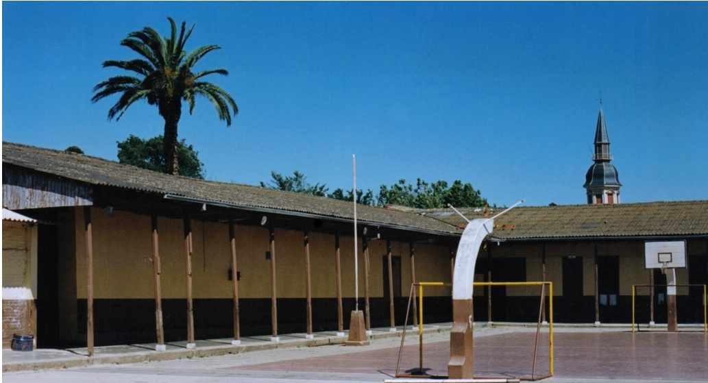
Figura 1.6: Antiguo patio central.
