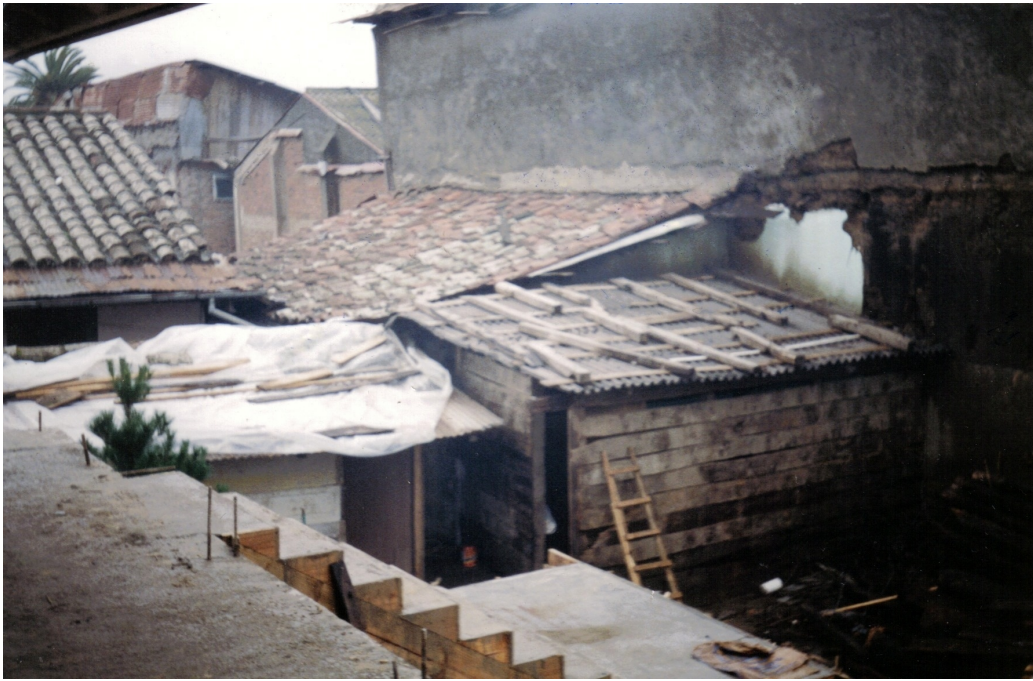
Figura 12.1: Se inicia construcción de salas por calle Portales, en 1989. Losa del segundo piso y escala de acceso.
