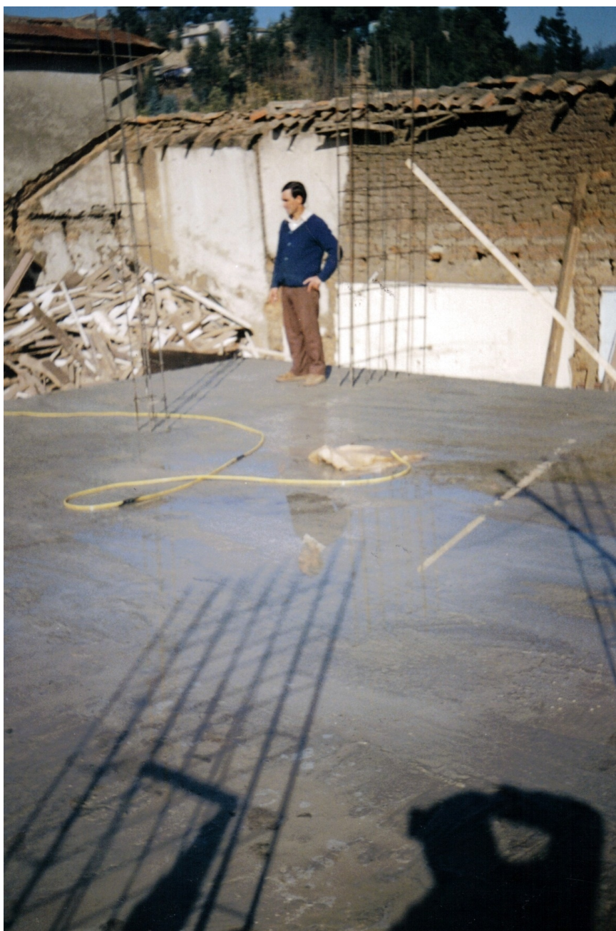
Figura 12.2: Construcción de primeras salas: losa segundo piso. Al fondo, muro lado sur límite de la propiedad del colegio (año 1989).
